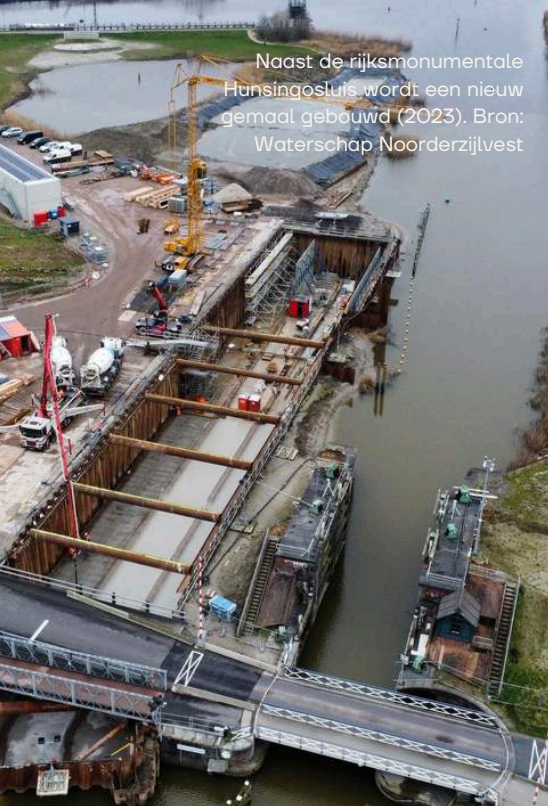
Ontwerp van de Hunsingosluys met het nieuwe gemaal. De keuze viel op een horizontale pomp zodat het nieuwe gemaal in zicht niet hoger is dan de historische sluis. Bron: Waterschap Noorderzijlvest
