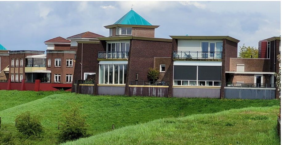
Waterkerende woningen bij Venlo. De plint van de woningen maken onderdeel uit van de constructie. foto: Joep Rawee
