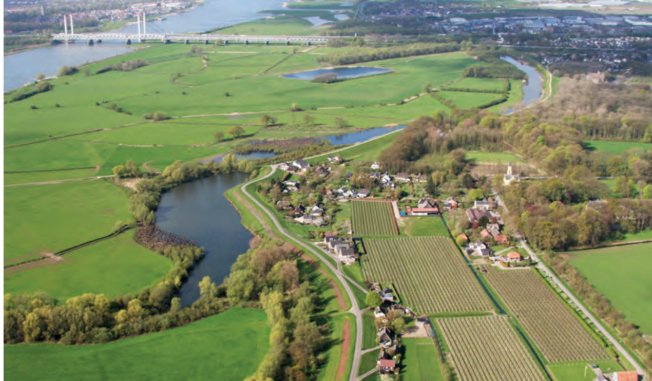
ensemble van dijk, bebouwing en strang in de Rijnswaard (foto Waterschap Rivierenland)
