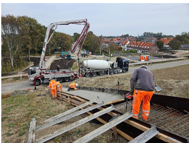
Figuur 12: Aanleg dijktrappen met in rechterkader gehele eindsituatie dijk
