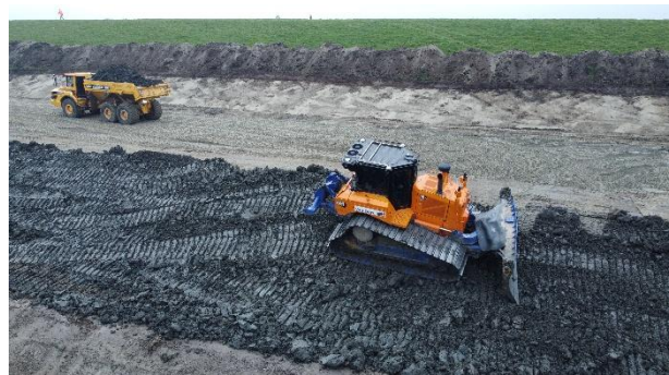
Figuur 8: Realisatie grondwerk voor verhoging kruin en aanbrengen steunberm met zand en klei
