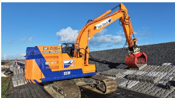
Figuur 10: Aanbrengen betonzuilen met hoog-laag patroon
