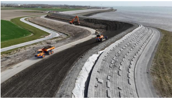
Figuur 8: Realisatie grondwerk voor verhoging kruin en aanbrengen steunberm met zand en klei
