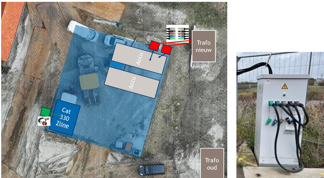
Figuur 19: Inrichting laadplein bij start project en powerlock station (rode blokken links en foto rechts)
