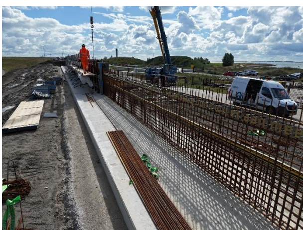
Figuur 11: Aanleg keermuur op kruin
