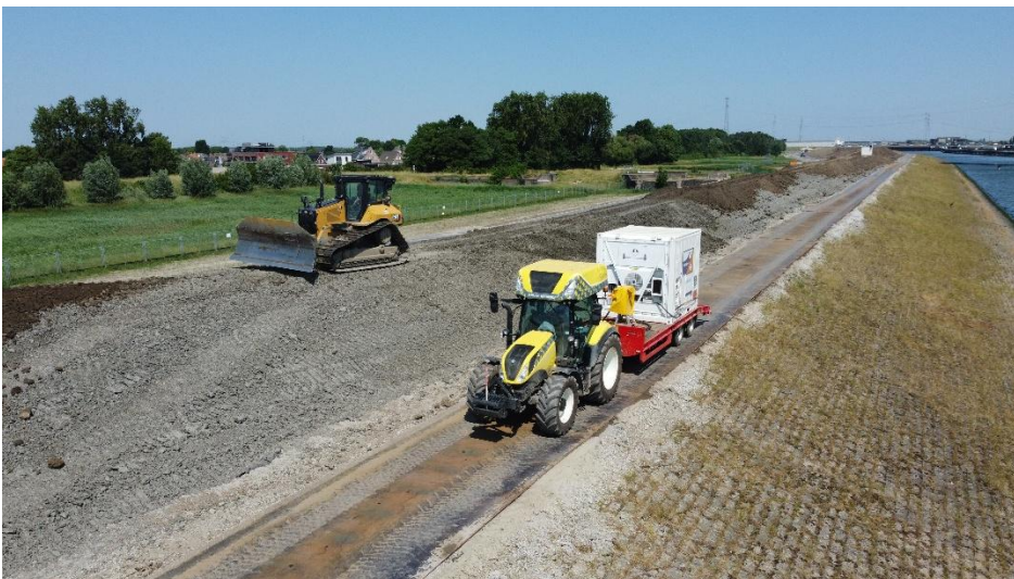
Figuur 23: Vervoer accupakket door op waterstof aangedreven trekker
