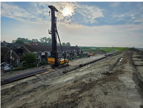
Figuur 9: Het drukken van damwanden in de binnenteen van de dijk
