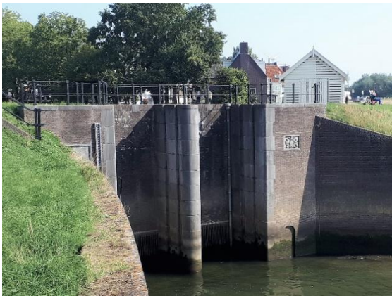
Figuur 10-2: Inlaatconstructie in het buitenhoofd van de Inlaatsluis Gemeentesluis (Links: Rivierzijde; Rechts: binnenzijde sluis)
