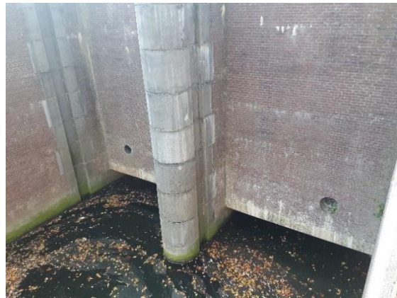
Figuur 10-2: Inlaatconstructie in het buitenhoofd van de Inlaatsluis Gemeentesluis (Links: Rivierzijde; Rechts: binnenzijde sluis)
